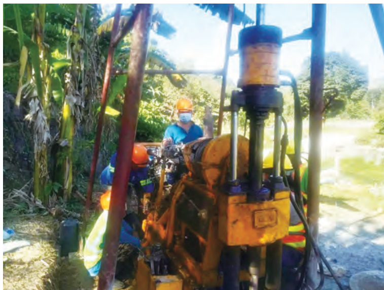
图 3-9 疫情期间卡里瓦大坝项目设计人员开展勘察测量工作
